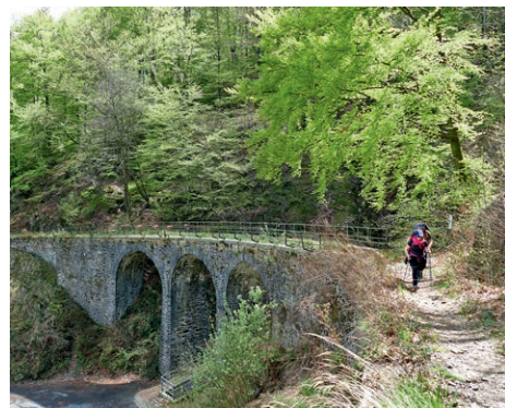
Il ponte dei Tre Archi a fianco della strada provinciale per Oropa
